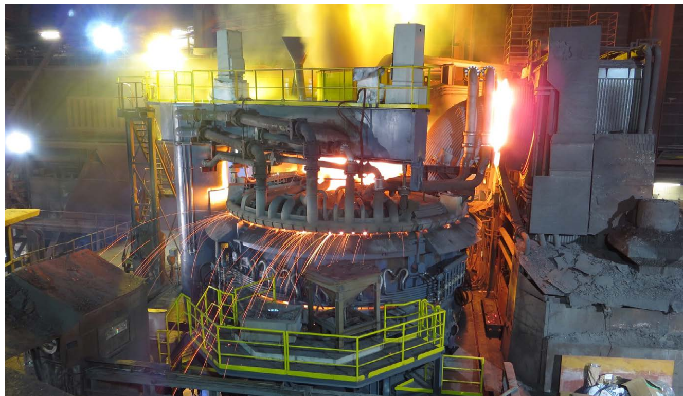
Four à arc électrique (EAF) de 160 t installé à l'usine ArcelorMittal Europe - Produits longs de Belval au Luxembourg
