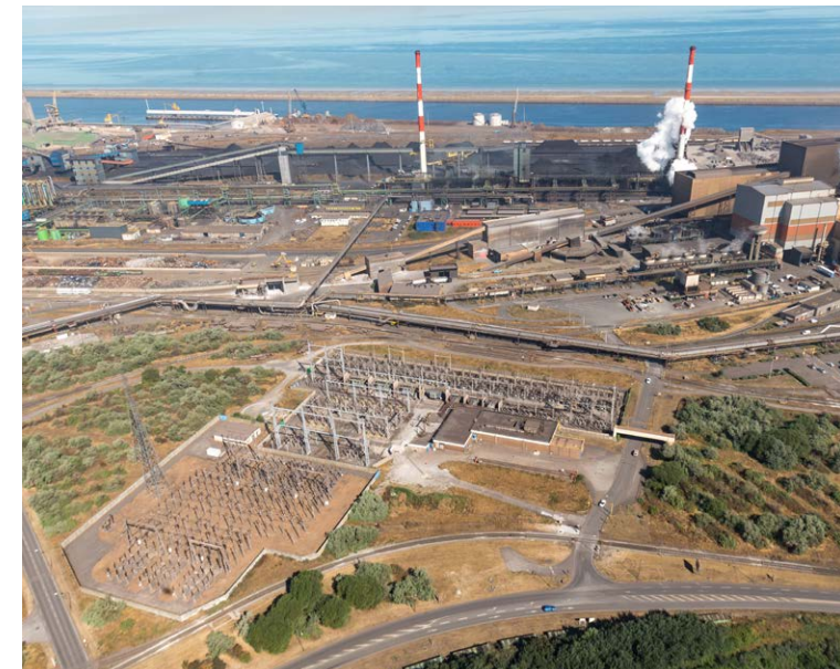
Postes électriques de Braek et de Prédembourg
