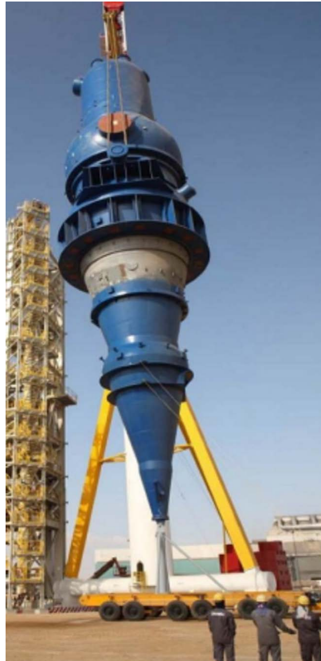
Transport et levage du réacteur de l'unité de réduction directe
